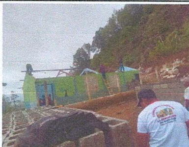
Foto1: Destechado de cubierta.
