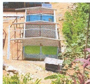
Foto: Vista panoramica colocacion de tijeras y costaneras de cubierta.
