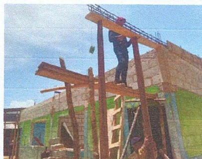
Foto 4: Elaboracion de vigas de concreto para el corredor.
