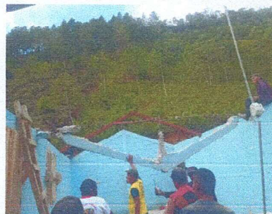
Foto 2: Remocion de solera deteriorada.
